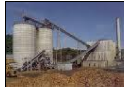
Nhà máy 150,000tấn sinh khối biomass
